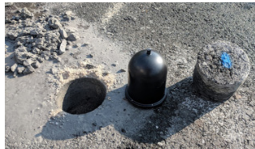
Jeden z parkovacích senzorů, nainstalovaných do povrchu parkoviště před budovou Fakulty elektrotechnické.
